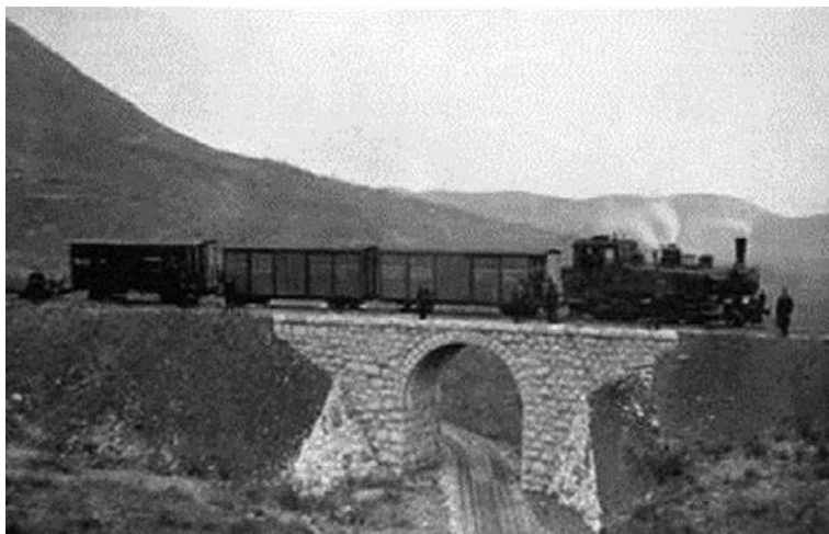
„Makina“ na vijaduktu Kalkavija, između željezničkih stanica Zupci i Tuđemili,
